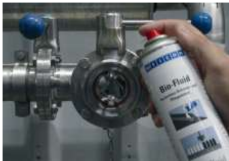
Lubrifierea supapelor de închidere
